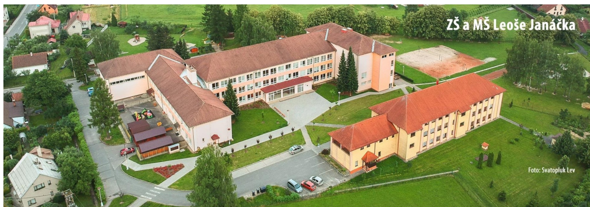
Obrázek č. 6: Základní a mateřská škola Hukvaldy
